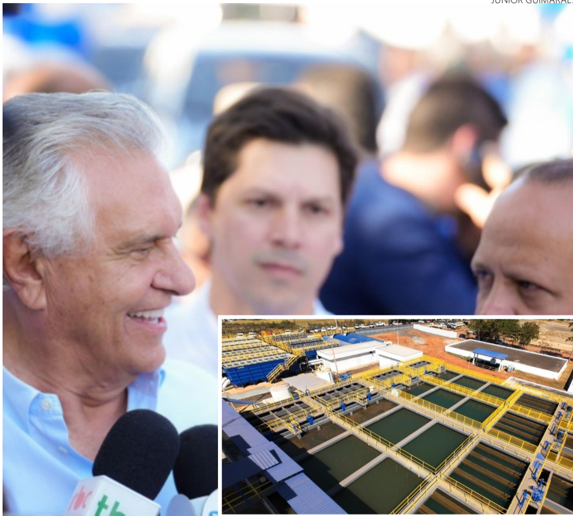
Governador Ronaldo Caiado e Daniel Vilela destacam importância da nova ETA (em detalhe) para Caldas Novas
